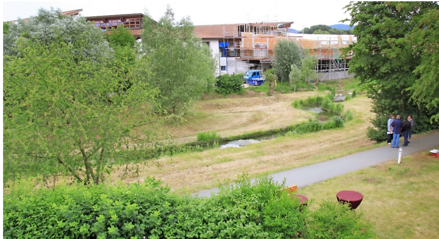
84 Meter sind zu überbrücken – der Bademantelgang wird vom ersten Stock des Kurhotels über den Lauterbach hinweg ins Thermalbad führen. Dort dockt der Gang direkt am derzeit neu errichteten Umkleidebereich an. Im Hintergrund ist die Baustelle des neuen Traktes der Therme zu sehen.
